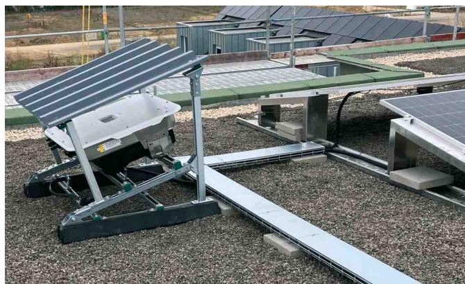
links: Die schallgeprüften Dämpfungssockel reduzieren Vibrationen und Lärmübertragung von Geräten.
