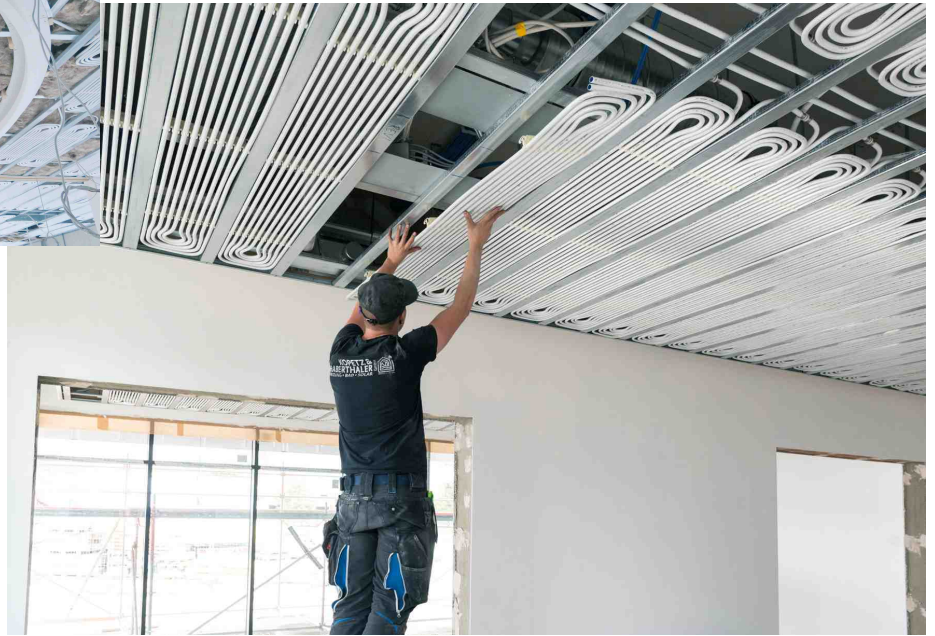
Der Installateur befestigt die Heiz- und Kühlelemente von Thermatop M an herkömmlichen Unterkonstruktionen, wie sie aus dem Trockenbau bekannt sind. Bild: Uponor
