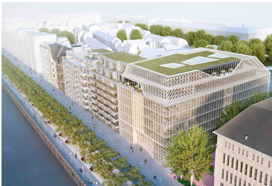
Prägendes Gestaltungselement des zehnstöckigen Neubaus ist eine filigrane, vertikal gegliederte Fassadenstruktur, die sich bis in die Dachschräge fortsetzt. Bild: HPP Architekten
