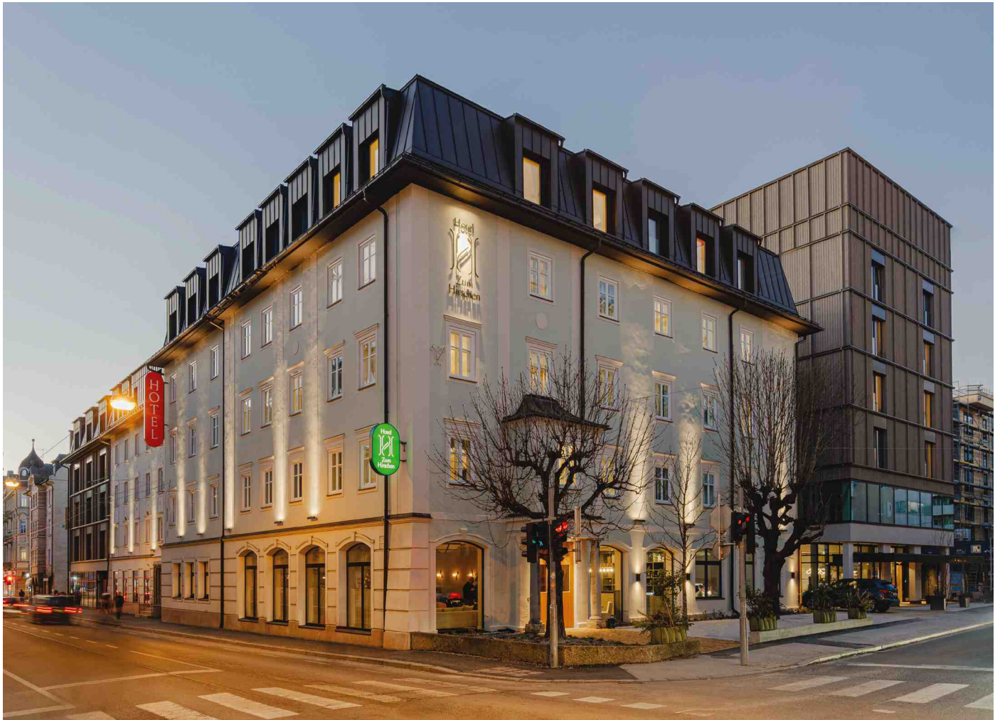
Das traditionsreiche Salzburger „Hotel zum Hirschen“ wurde umfassend umgebaut. Nachhaltigkeit spielte bei der Planung und Umsetzung des Projekts eine zentrale Rolle.
