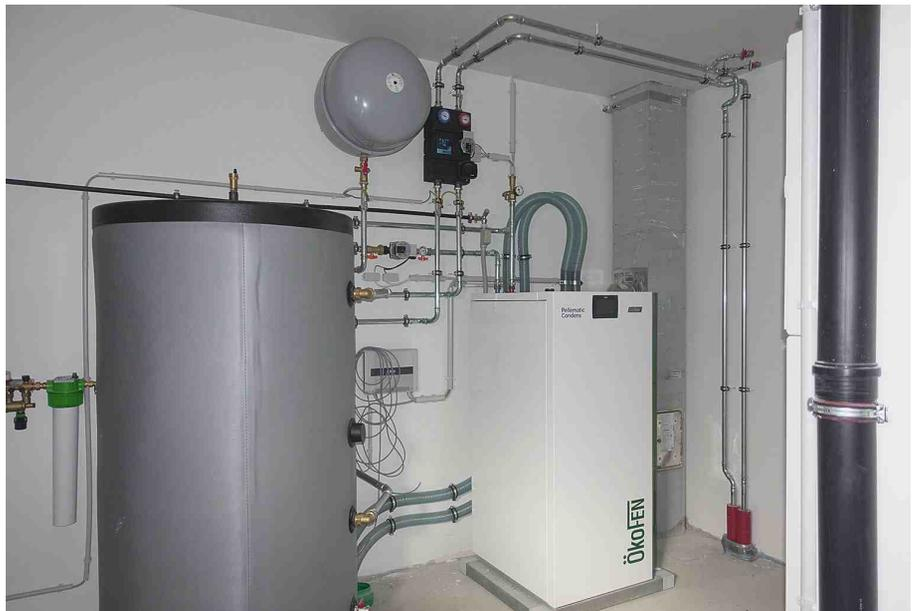
Brennwert-Holzpelletkessel des Herstellers ÖkoFEN. Links im Bild der Pufferspeicher für das Heizungswasser.
