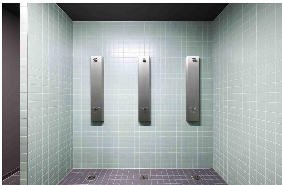
Viele Sanierungsmaßnahmen können durchgeführt werden, ohne den Gebäudebetrieb zu unterbrechen. Dazu sind Schell Produkte und Lösungen besonders einfach installierbar. So sind z. B. Duschpaneele leicht austauschbar, bestehende Anschlüsse können genutzt bzw. kaschiert werden.
