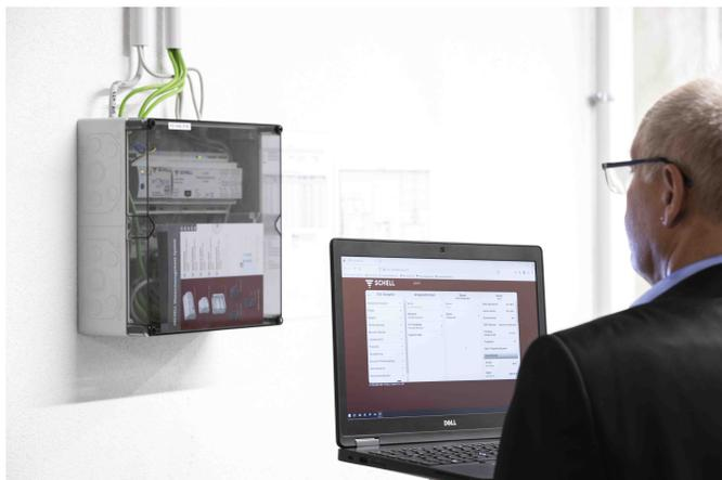
Zur Unterstützung beim Erhalt der Trinkwassergüte lässt sich das Schell Wassermanagement-System SWS nachrüsten. Die Vernetzung der Schell Armaturen mit dem SWS Server erfolgt wahlweise per Kabel und/oder Funk.
