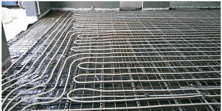
Die Lebensdauer von PE-Xa-Rohren entspricht mindestens der Nutzungszeit eines Gebäudes. Das gilt selbst dann, wenn die Rohre Kratzer bei der Befestigung auf den Baustahlmatten oder beim Einbringen des Walzbetons bekommen haben.
