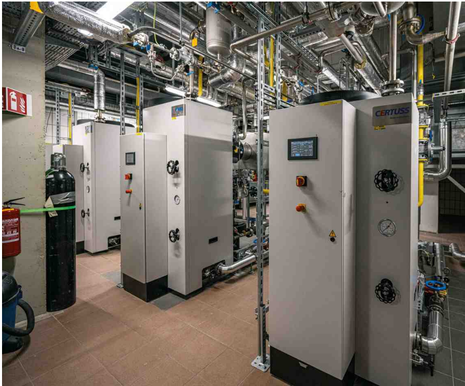
1 CERTUSS Dampfkessel Typ 500 (364kW), 2 CERTUSS Dampfkessel Typ 850 (619kW), v.r.n.l.
