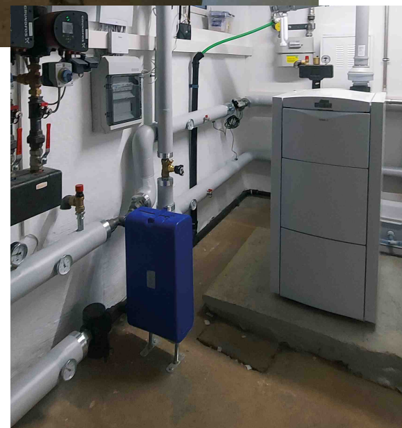
Die modernen Vaillant Gas Brennkessel (VKK 656/4 ecoVIT) sind die optimale Lösung für das Almgebäude.
