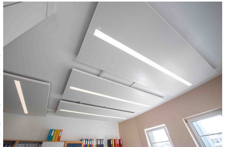
Die Metalldeckensegel sind schnell montiert und optisch ansprechend.
